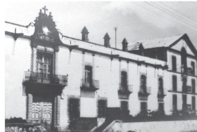
Imagen 2.22. Vista panorámica de la fachada de la Hacienda de Santa Mónica. Se encuentra en el municipio de Tlalnepantla, Estado de México.
