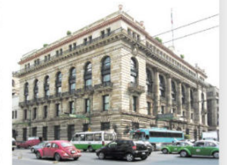
Imagen 5.10. Edificio del Banco de México en el centro de la Ciudad de México.
