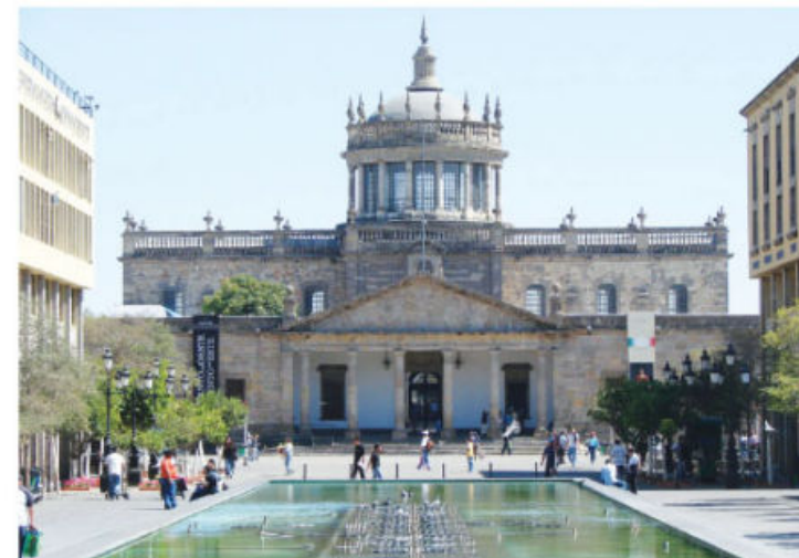
Imagen 3.41. El Hospicio Cabañas, ubicado en la ciudad de Guadalajara, Jalisco, construido por Manuel Tolsá.
