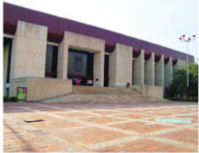
Imagen 4.20. Edificio del IPN Zacatenco, en la Ciudad de México.
