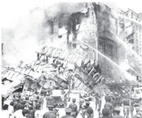
El terremoto de 1985 ocasionó daños importantes a la Ciudad de México.
