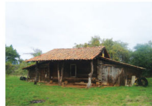
Imagen 2.43. Casa construida con techo de tejamanil.
